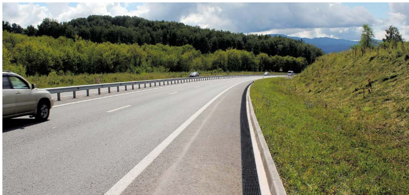
г. Новосибирск, съезд с трассы, водоотводные лотки BGS-S с чугунными решетками
