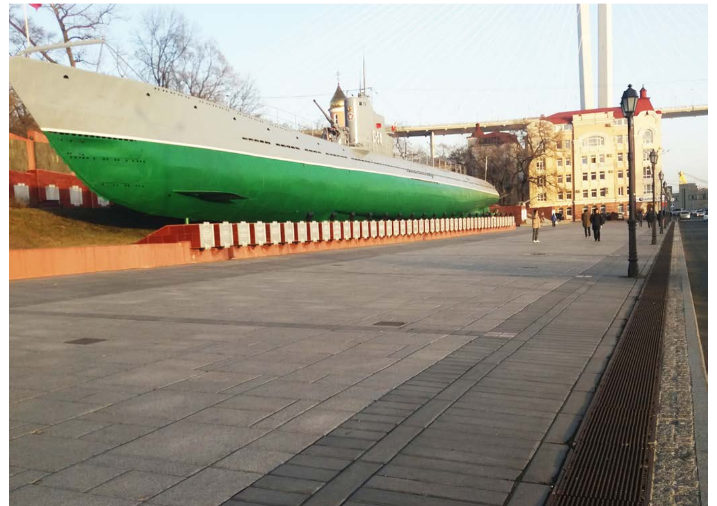
г. Владивосток, Мемориал "Боевая слава Тихоокеанского флота", водоотводные лотки BGZ-S с чугунными решетками
