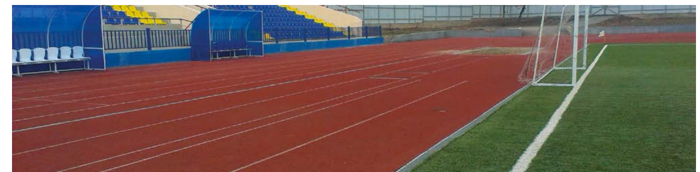
Стадион г. Новошахтинск, водоотводные лотки Gidrolica® Standart Plus со стальными оцинкованными решетками
