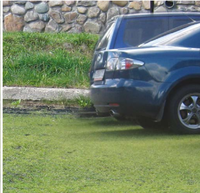
г. Москва, ресторан Ермак, Экопарковка
