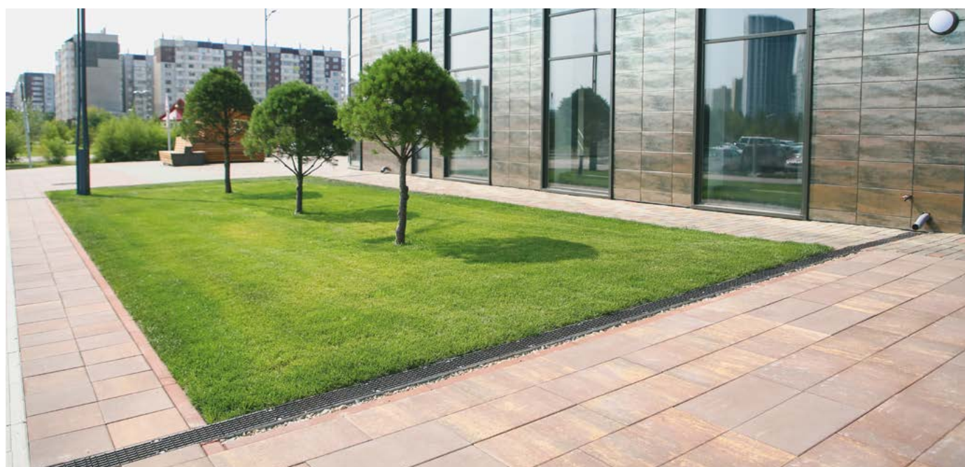
г. Красноярск, ЖК "Скай Севен", водоотводные лотки BGU-Z
