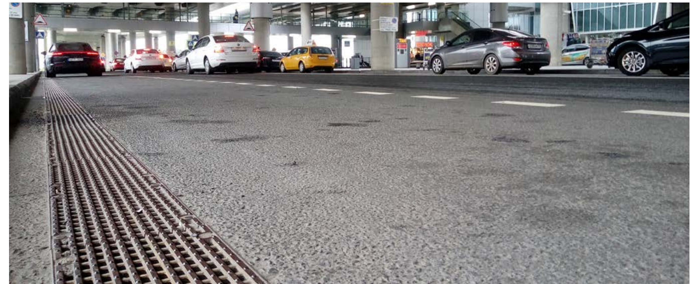
г. Санкт-Петербург, аэропорт Пулково, проезжая часть
