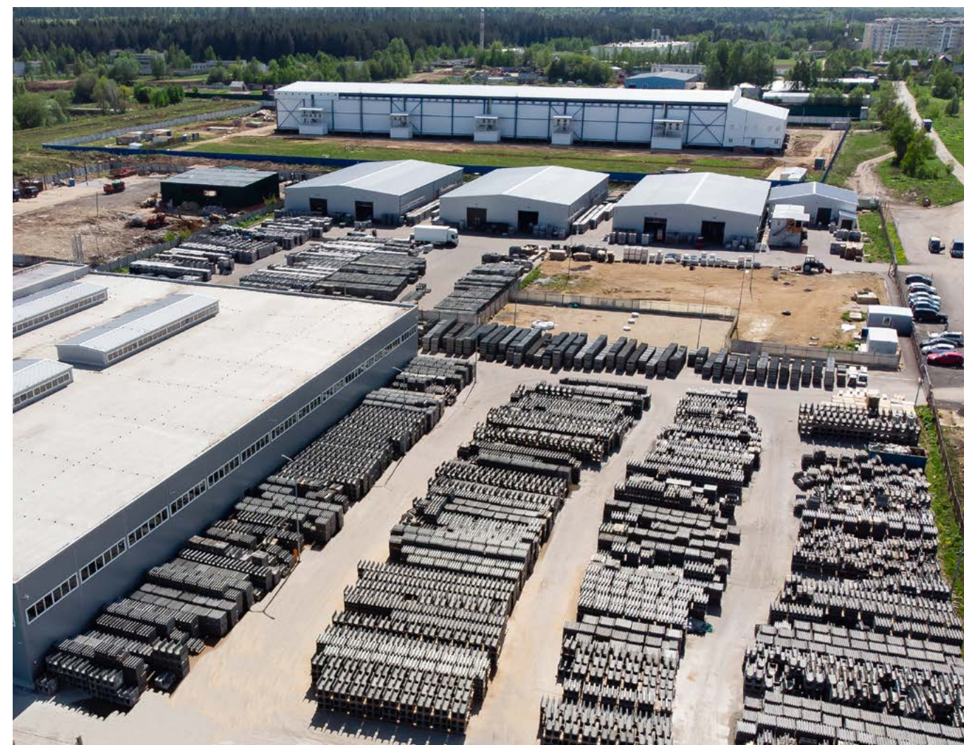
Производство водоотводных систем "Gidrolica" в г. Звенигороде.
