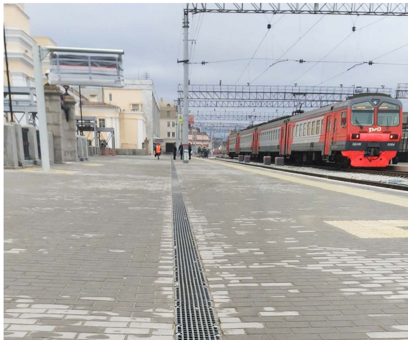
г. Екатеринбург, Ж/Д вокзал, водоотводные лотки BGZ-S
