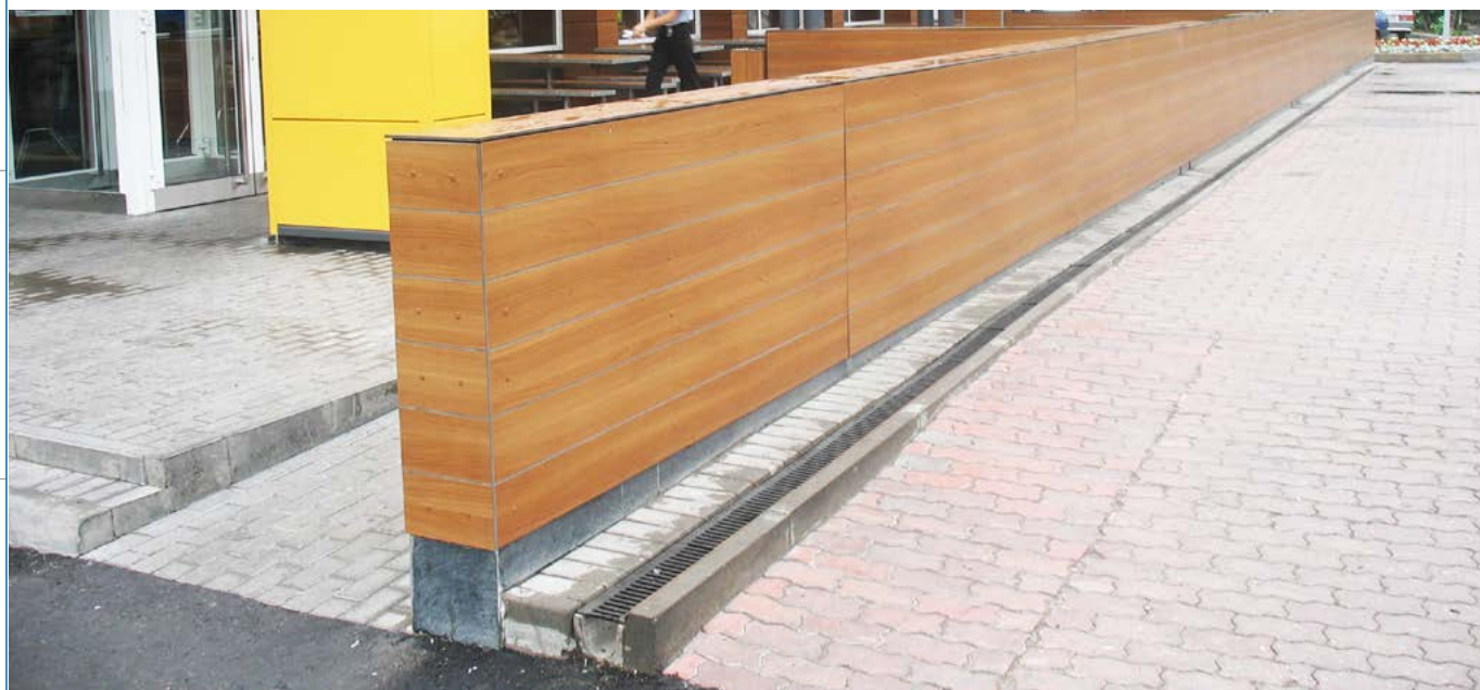
г. Балашиха, ресторан "Макдоналдс" водоотводные лотки BGU с чугунными решетками
