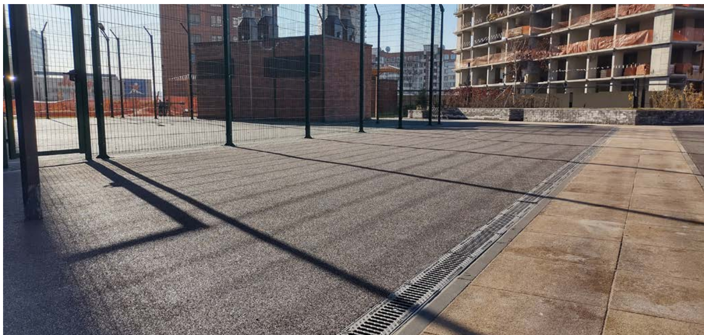
г. Новосибирск, пластиковые лотки Hidrolica Standart Plus, жилой комплекс
