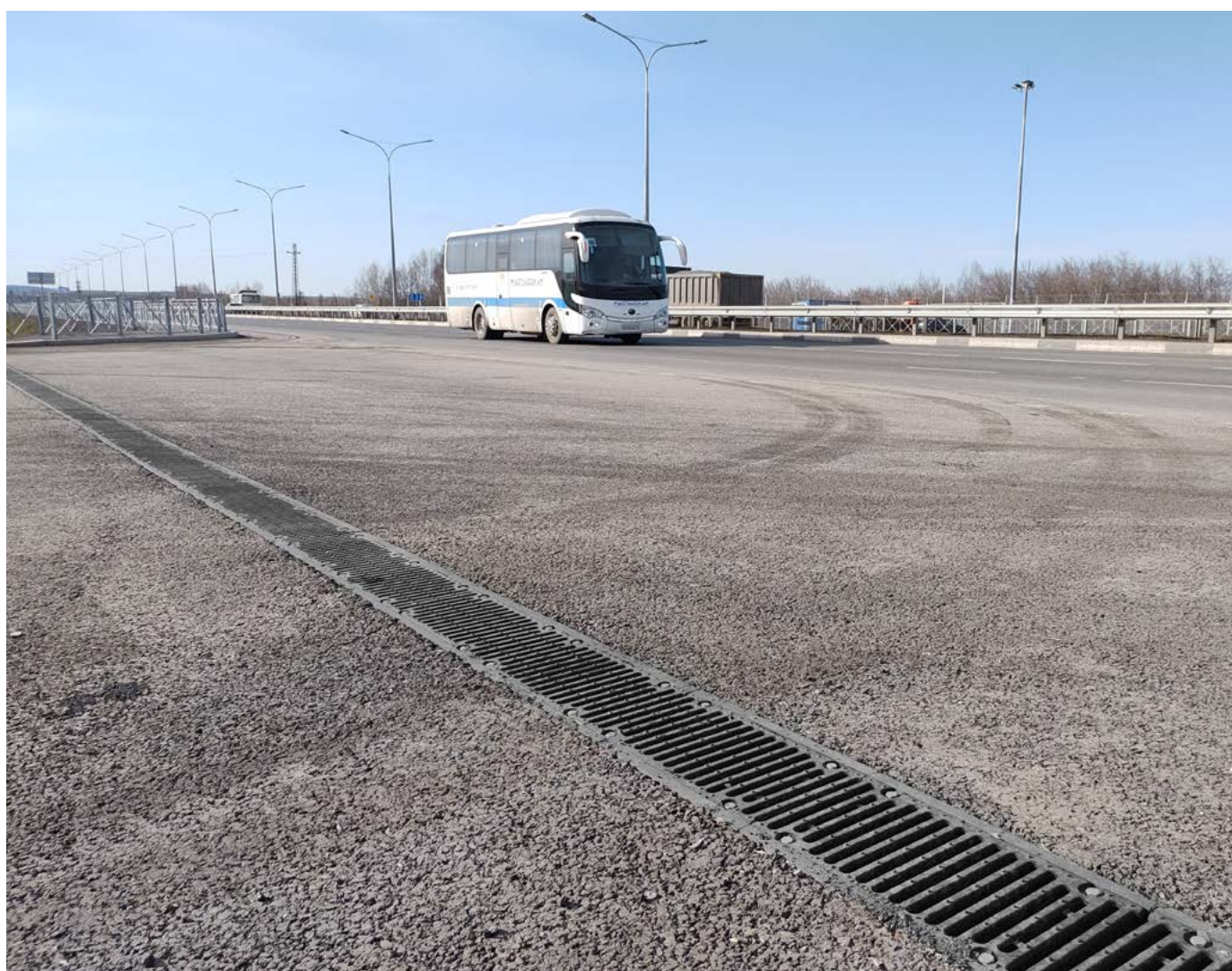
г. Новокузнецк, Кемеровская обл., шоссе, бетонные лотки BGZ-S
