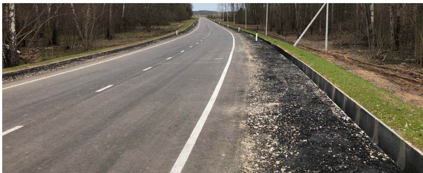
Московская область, бетонные водоотводные лотки BGU, кюветное использование
