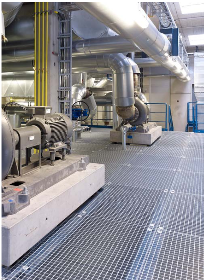
г. Новосибирск, производственные помещения, сварной настил
