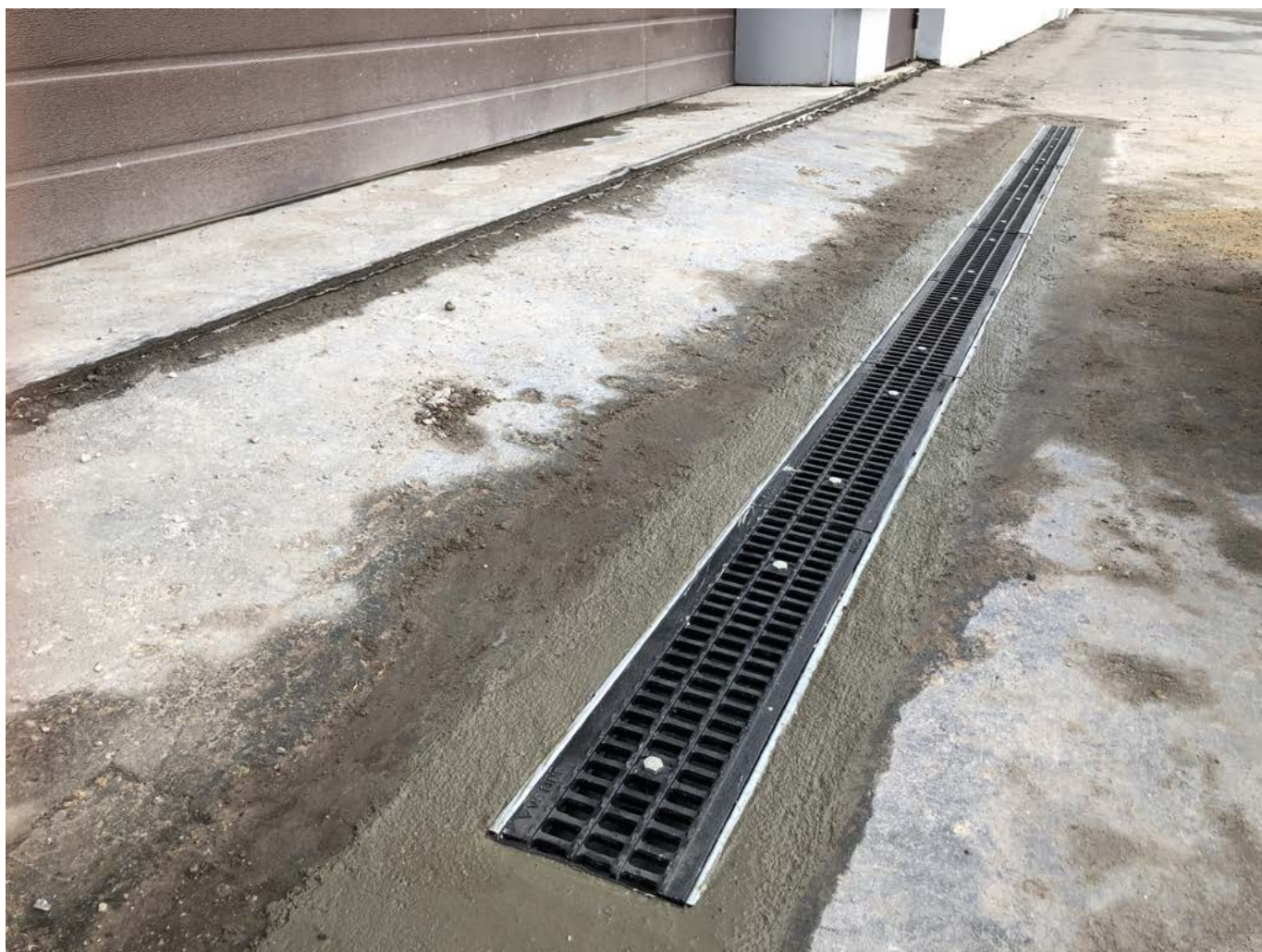
г. Звенигород, Московская область, въезд в производственный цех, лотки VS Line DN100 с высотой 53 мм, чугунная решетка C250
