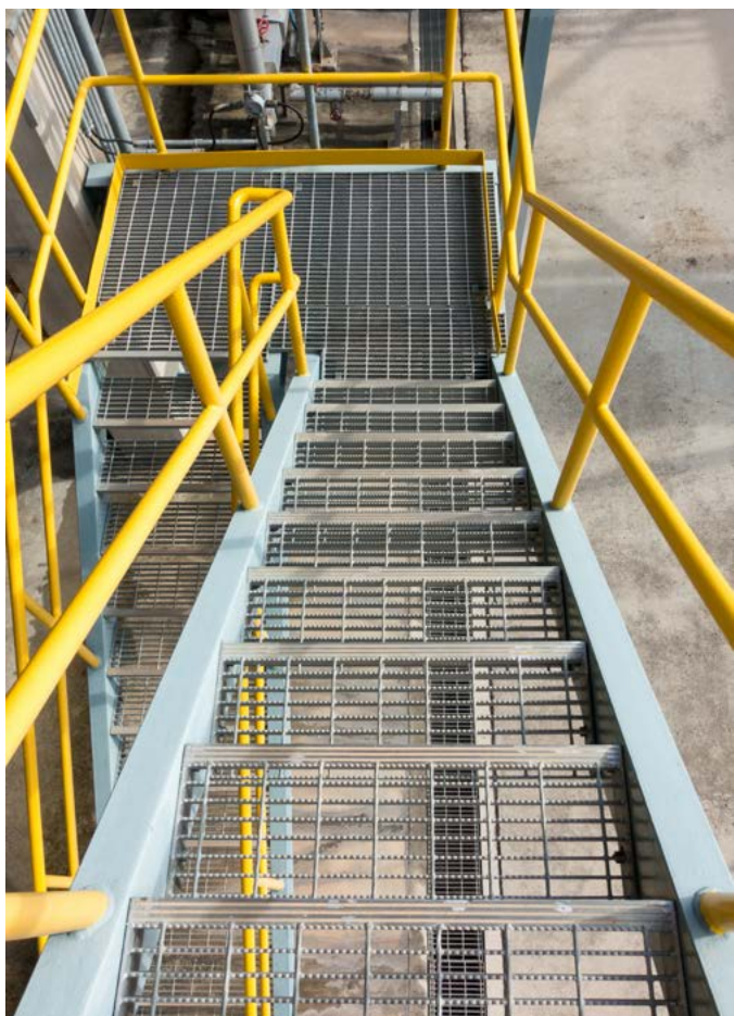
Московская обл., г. Звенигород, склад, лестничные ступени
