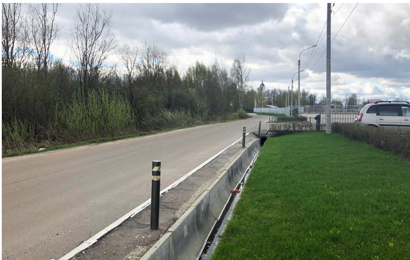
Московская область, бетонные водоотводные лотки BGU, кюветное использование
