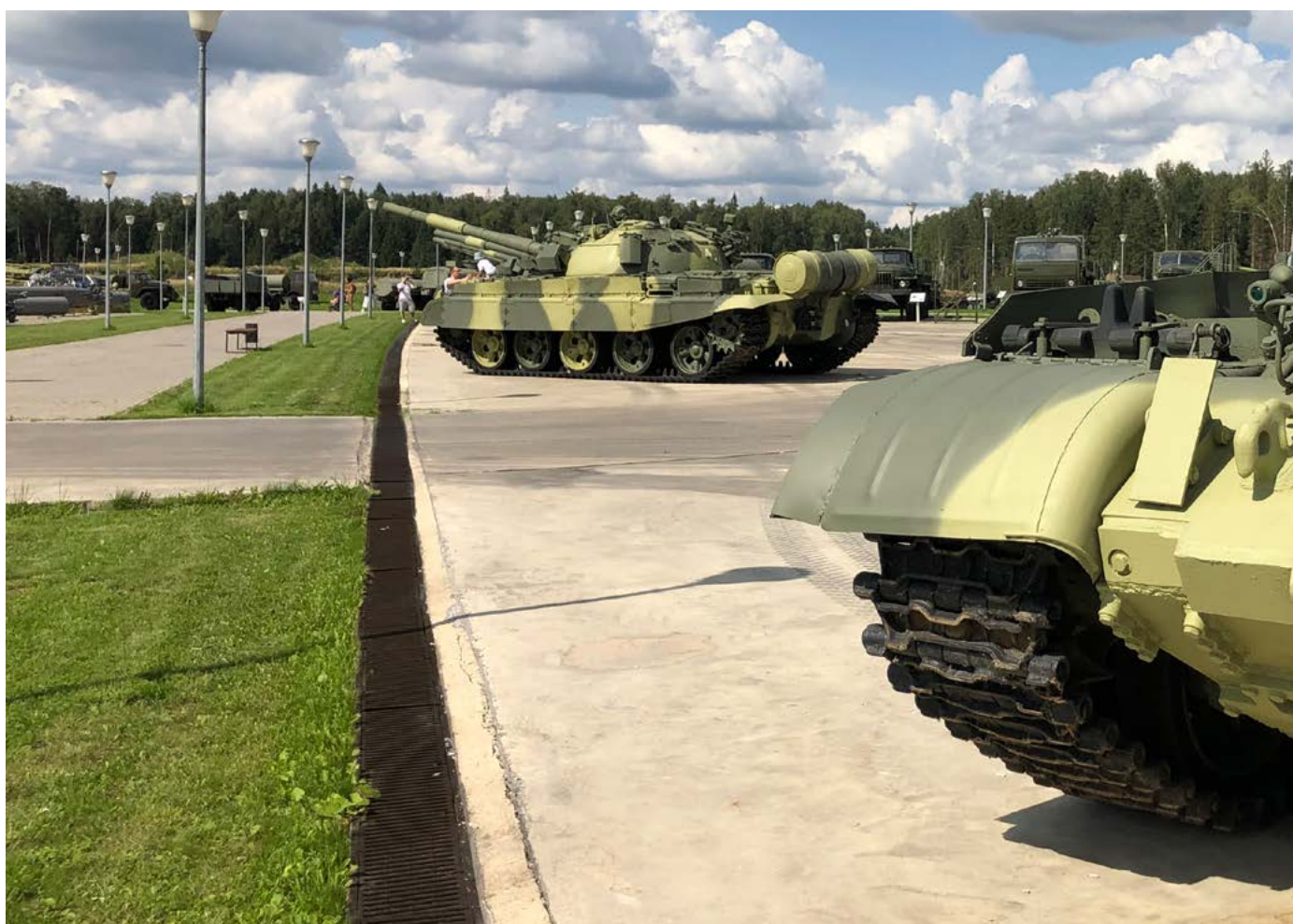
Московская обл., парк "Патриот", бетонные лотки BGZ-S
