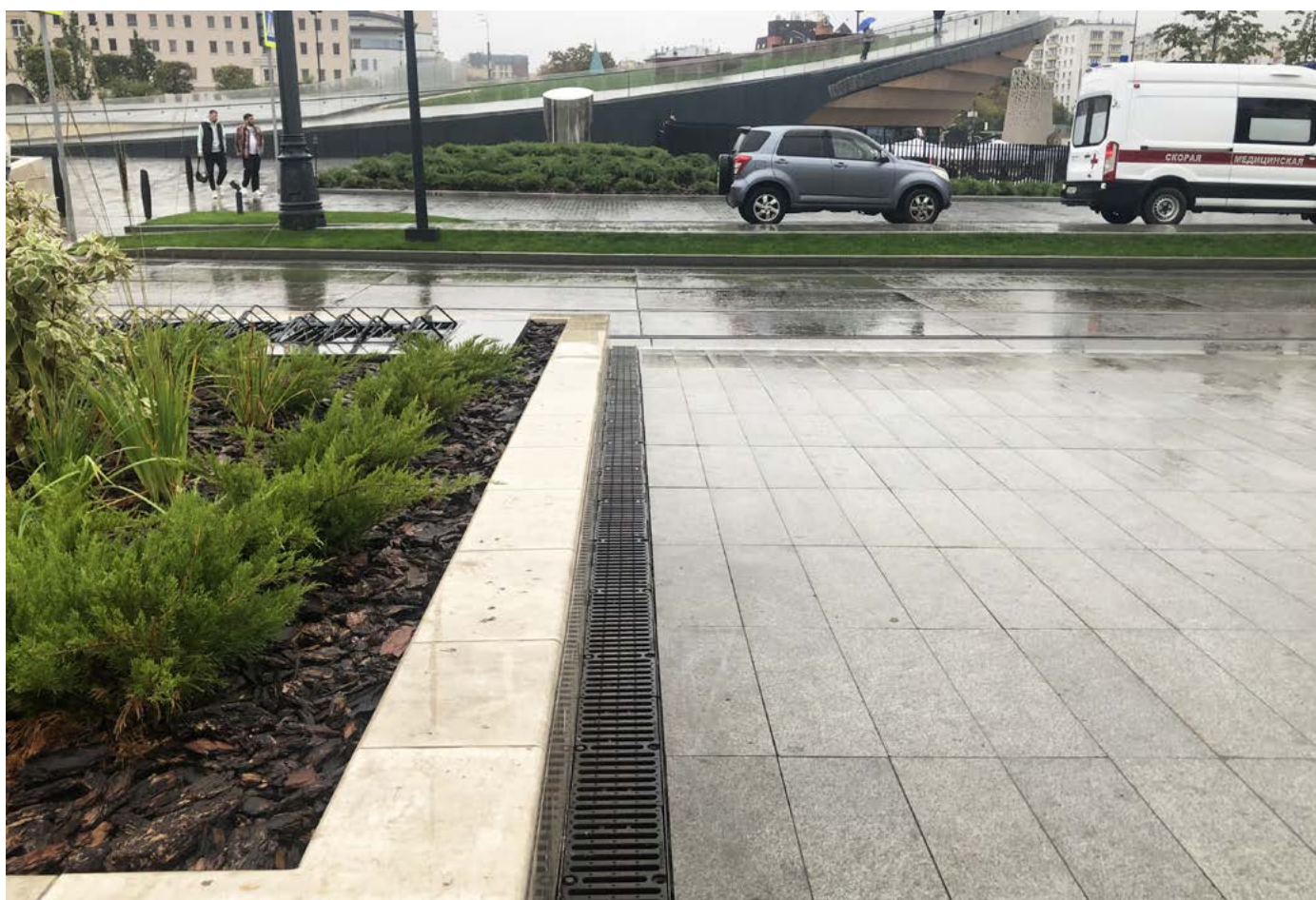
г. Москва, Павелецкий вокзал, бетонные лотки BGF-Z
