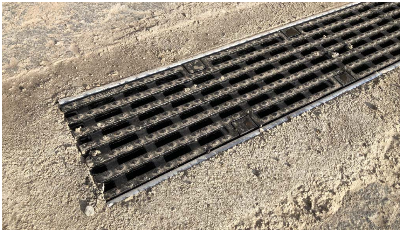
г. Звенигород, Московская область, въезд в производственный цех, лотки VS Line DN100 с высотой 200 мм, чугунная решетка D400
