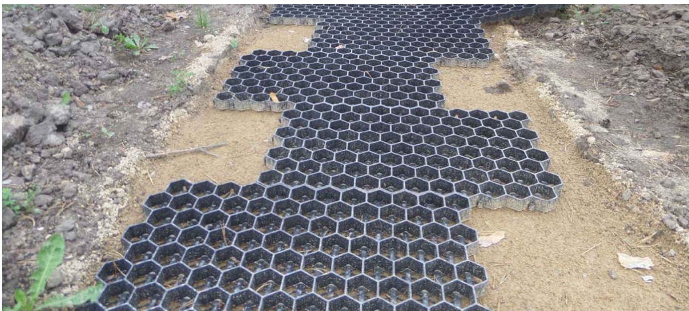
Создание садовых дорожек на частном участке, газонная решетка Eco Standart
