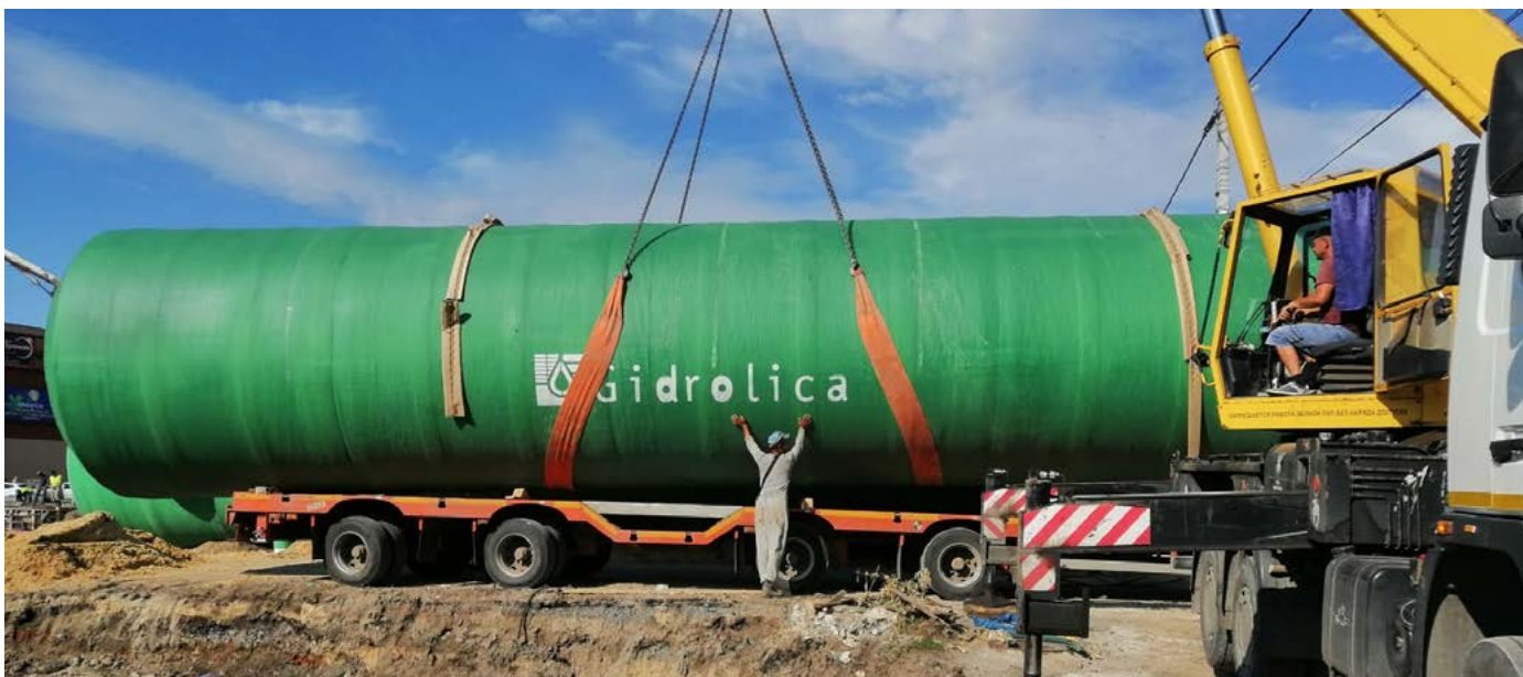
с. Новая Усмань, Воронежская обл., благоустройство города, емкость стеклопластиковая Gidrolica Tank Water
