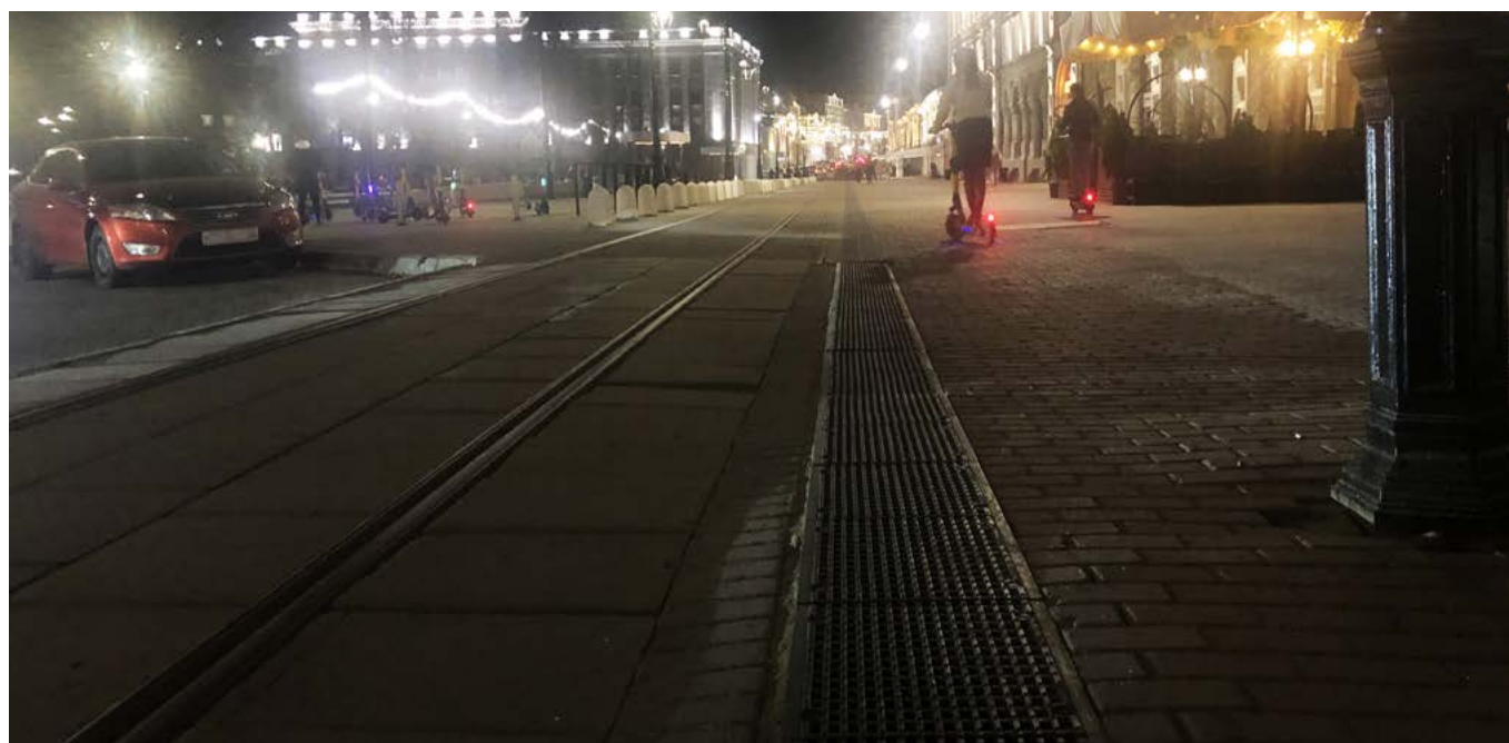
г. Нижний Новгород, ул. Рождественская, бетонные лотки BGZ-S
